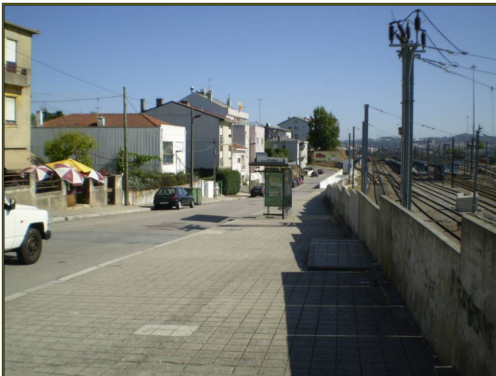
Fotografia 3.6.3 - Continuação da Rua Conde Castelo Melhor à Aproximação de Contumil
