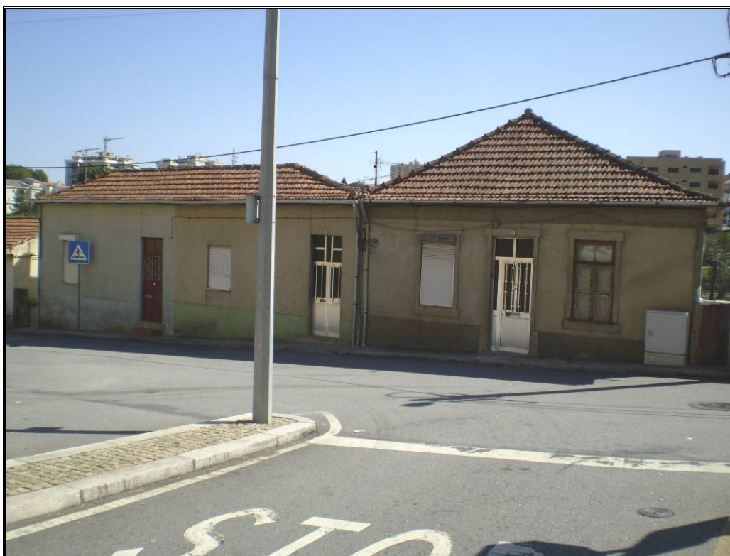
Fotografia 6.4.1 - Duas Habitações da Rua de Vila Cova a Serem Afectadas
