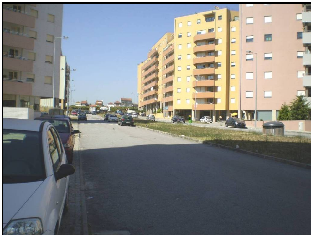
Fotografia 3.6.11 - Edifícios junto à Paragem de Venda Nova
