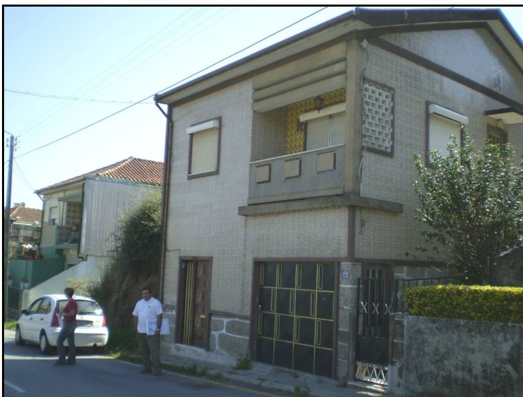
Fotografia 6.4.2 - Uma Habitação da Rua de Repelão a ser Afectada
